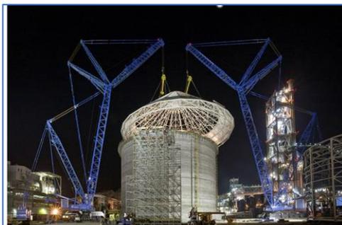
Liebherr-Raupenkraner heben das Dach auf ein 30m hohes Mischsilo in einem Zementwerk in Polen.
